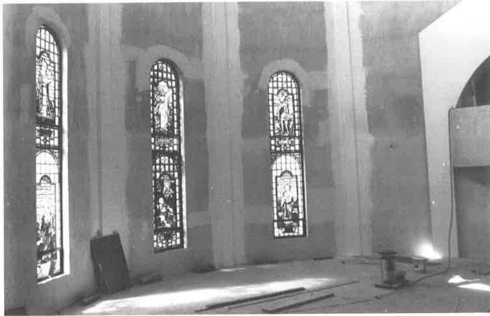
Interior: the nave April, 1980
